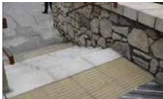
រូបភាព ១.២.៤.៣. គំរូអំពីការរៀបចំឥដ្ឋឆ្លុះរំលេចសម្រាប់ជនមានពិការភាពភ្នែកនៅចំណុចចាប់ផ្តើមនិងចុងបញ្ចប់ នៃជណ្តើរ នៅខាងក្រៅ
