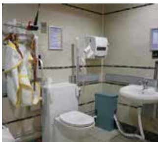
រូបភាព ៥.៣.២.១. គំរូអំពីបង្គន់សម្រាប់ភេទច្រើននៅចំណុចដែលមានឧបករណ៍ស្ទូចលើកដាក់ជនមានពិការភាព
