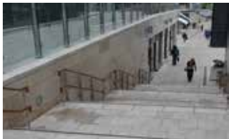
រូបភាព ១.២.៤.២. គំរូអំពីជណ្តើរខាងក្រៅ ផ្ទៃឆ្លុះរំលេចចុងខាងលើនិងចុងខាងក្រោមនៃជណ្តើរដែលមាន ពណ៌ឆ្លុះរំលេចទាំងនៅតាមបង្កាន់ដៃនិងកន្លែងសម្រាក
