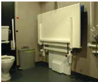
រូបភាព ៥.៣.២.២. គំរូអំពីបង្គន់សម្រាប់ភេទច្រើននៅចំណុចដែលមានកន្លែងផ្លាស់ប្តូរសម្លៀកបំពាក់ដោយជំនួយ
