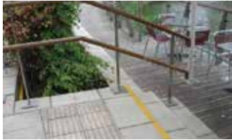
រូបភាព ១.២.៤.១. គំរូអំពីឥដ្ឋឆ្លុះរំលេចពណ៌ចុងខាងលើជណ្តើរនិងបង្កាន់ដៃពីរជាន់ដែលមានពណ៌ផ្ទុយពីផ្ទៃ
